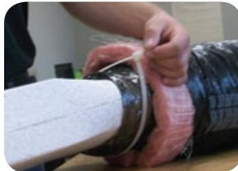
Raccorder les conduits flexible isolé aux transitions isolé à l'aide des colliers de serrage. Tirez l'isolation et la barrière de vapeur des conduits au-dessus des transitions isolé. Sceller le joint avec un ruban adhésif sans comprimer l'isolation jusqu'à étanchéité complète.
